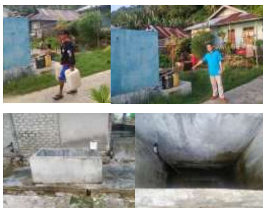
Gambar 5. Kondisi Sumur Warga Desa Kulingkinari
