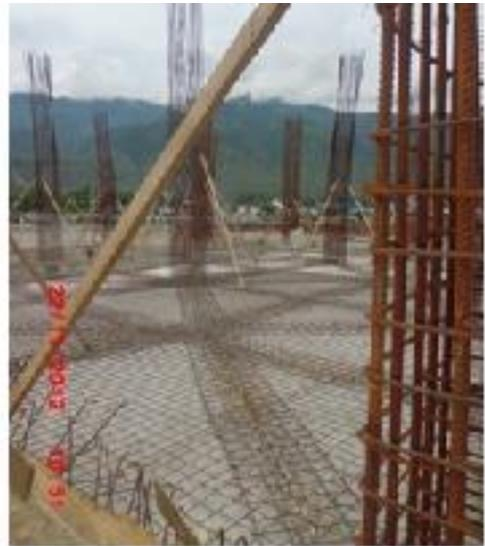
**Gambar 9.** Pemasangan pembesian slab
